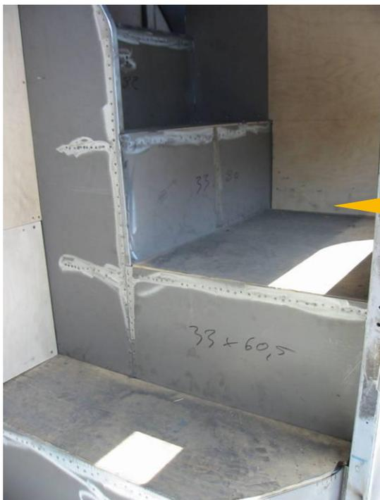
二階に通じる階段はクライアントと確認しながら、手作業で製作並びに設置される。
