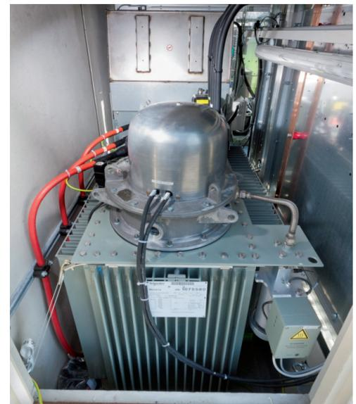
**Bild 3.** Der regelbare Ortsnetztransformator
