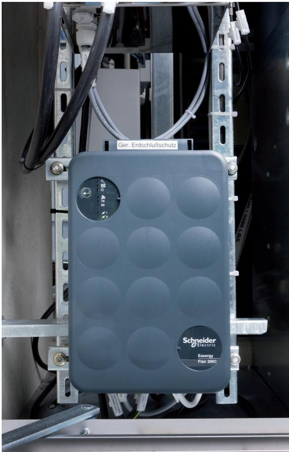
Bild 4. Die Fernüberwachungseinheit Easergy Flair 200C
