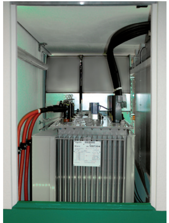
➤ Mechanisch regelbarer Ortsnetztransformator (RONT)
