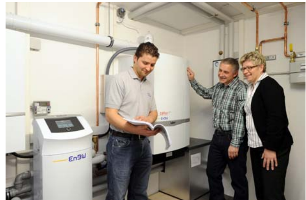
Brennstoffzellen-Heizgeräte in Wohngebäude sorgen für eine effiziente Wärme- und Stromproduktion. (Quelle: Callux)
