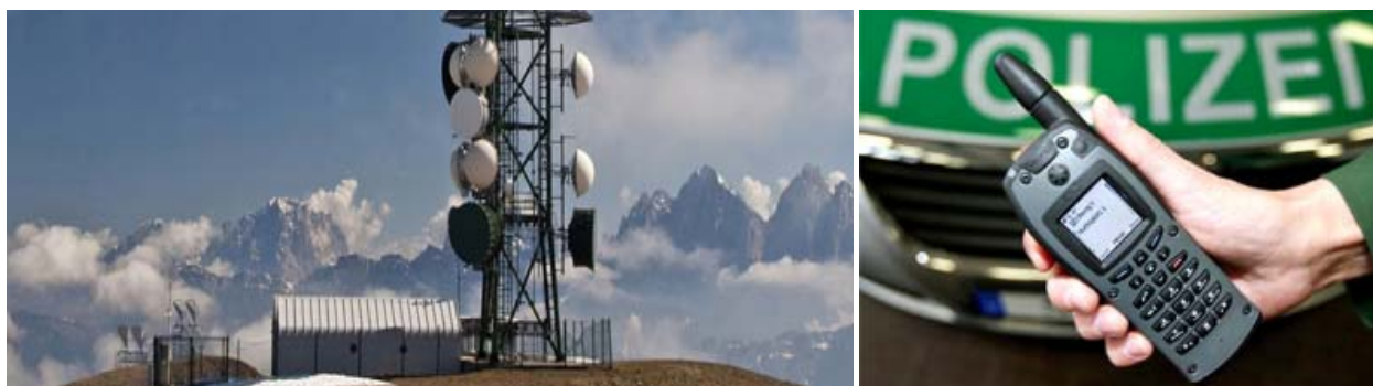
Sichere Stromversorgung mit Brennstoffzellen in der Telekommunikation und im Behördenfunk (Quelle: Heliocentris, CPN)
